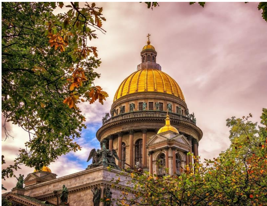
Figura 1.3. Catedral de San Isaac (siglo XXI), en San Petersburgo. Cúpula recubierta por una película delgada de oro depositada mediante la técnica de “gilding”.
